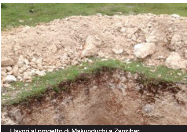
I lavori al progetto di Makunduchi a Zanzibar
