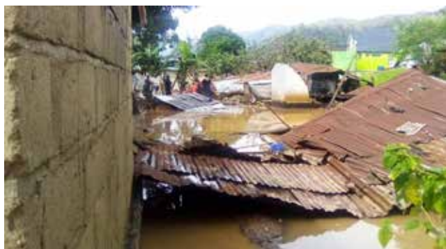
I danni dell'alluvione a Uvira, Sud Kivu
