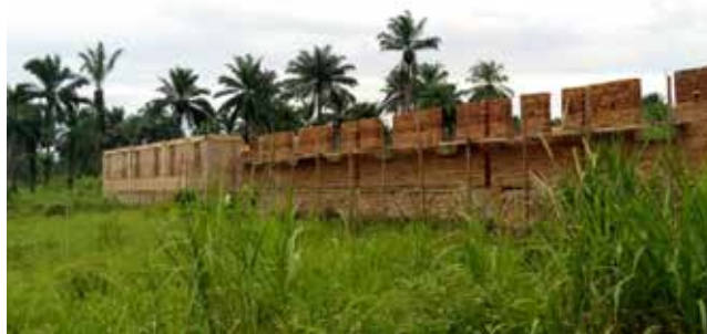
I lavori per la costruzione della Casa Rifugio
