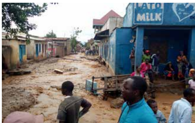
I danni dell'alluvione a Uvira, Sud Kivu
